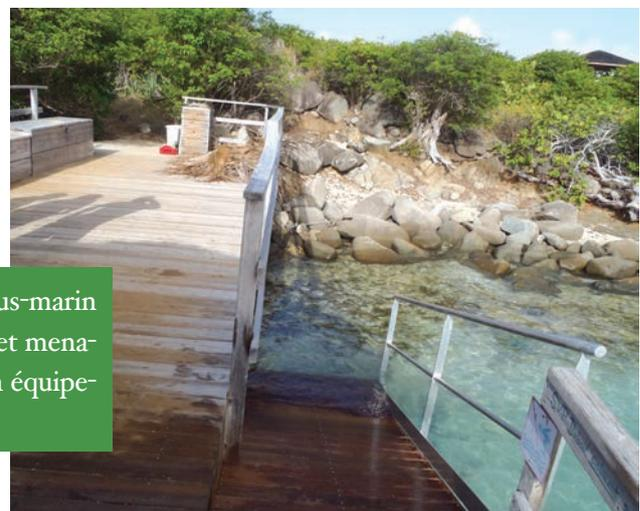
La passerelle de mise à l'eau à l'entrée du sentier sous-marin de Pinel, qui présentait des signes de dégradation et menaçait la sécurité des usagers, a été remplacée par un équipement flambant neuf, en aluminium et en bois.
