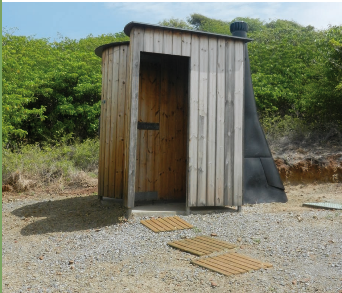
Toilettes sèches à Pinel Dry toilets on Pinel © Béatrice Galdi
