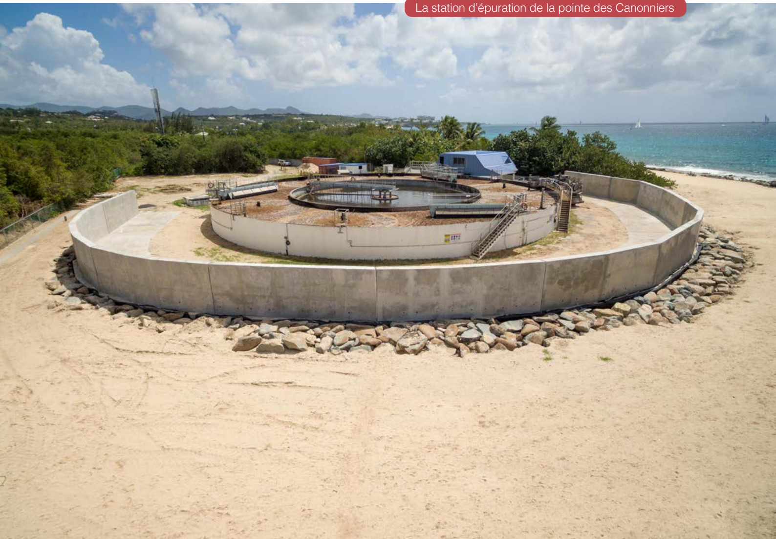
La station d'épuration de la pointe des Canonnières
