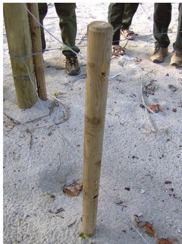
FDL Martinique, poteaux en pin traité, avec percements pour passage des fils. (Photo ONF Guadeloupe)
