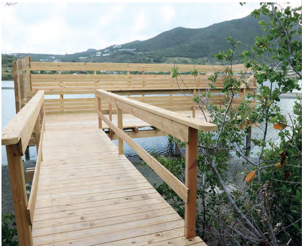
L'observatoire aux oiseaux de l'étang de Chevrise The bird observatory at the Chevrise salt pond
