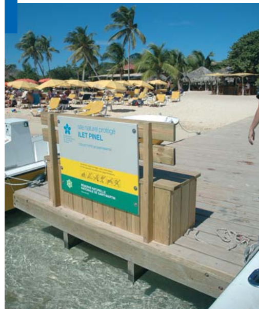
Le nouveau ponton de Pinel permet un accostage en toute sécurité
