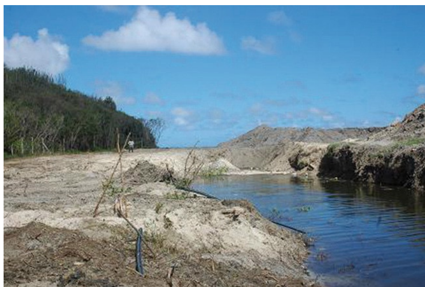
Avant – En 2009, mise en place d'un remblai et défriement de la mangrove
