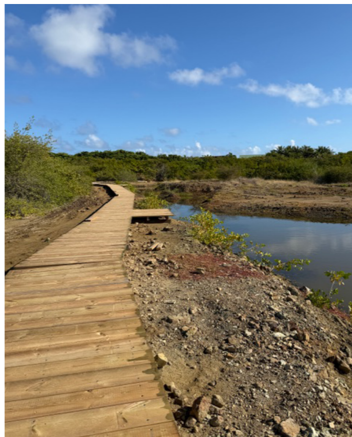
▲ Aménagement du platelage.
