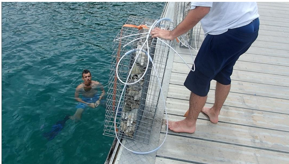
Figure 9 : photographie de l'installation des Biohut® à la marina Fort-Louis
