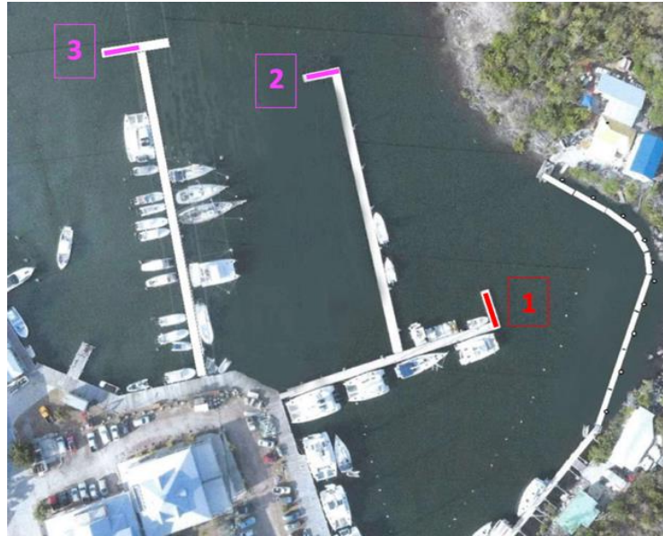
Figure 8 : photographie aérienne de la marina de l'Anse Marcel et localisation des linéaires
