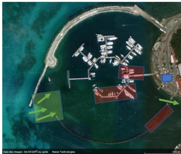
Marina Fort Louis, photographie aérienne
