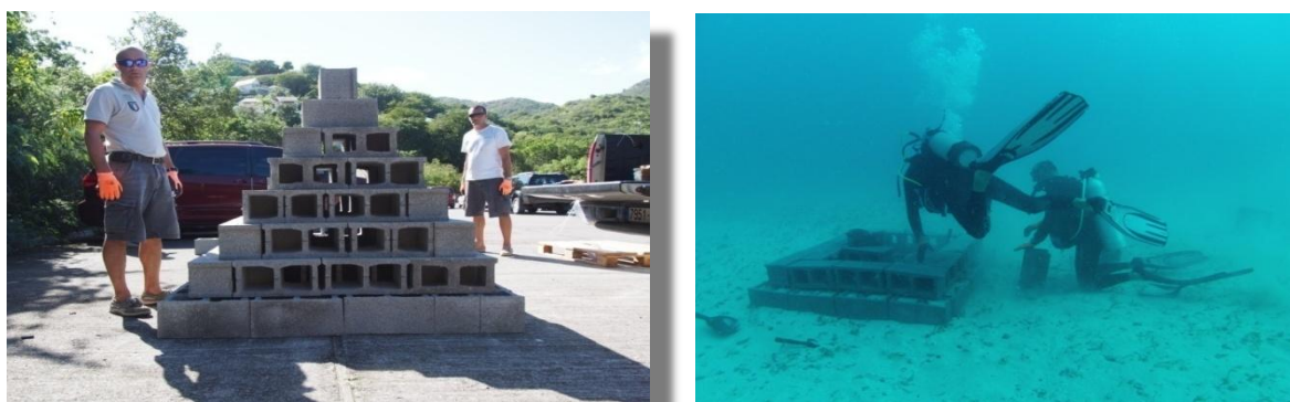
Figure 1 et 2 : Essai de construction à terre et construction sur site, Julien Chalifour.
